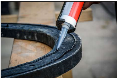
Izbūvējot polimēra lūkas pārsedes elementus vienu virs otra jālieto silikona mastika, Ø 3-5 mm divās joslās, uz polimēra elementa virsmas!
